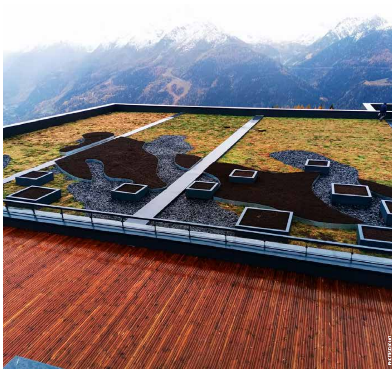
Au nouveau Club Med de La Rosière, c'est Claire Cholat et les architectes paysagés JBS Associés qui sont intervenus. Un chantier conséquent caractérisé par cet immense toit végétalisé avec des variétés de sédum.
